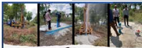
井戸掘削作業
